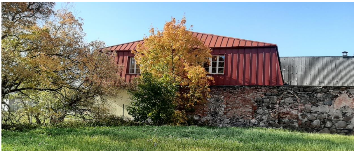
Foto 2 Vaade krundi läänenurgale, kinnistu piiriga külgnevale Fr. Tuglase 12 hoone otsaküljele ja miljööväärtuslikule maakividest ning tellistest ehitatud piirdemüürile
